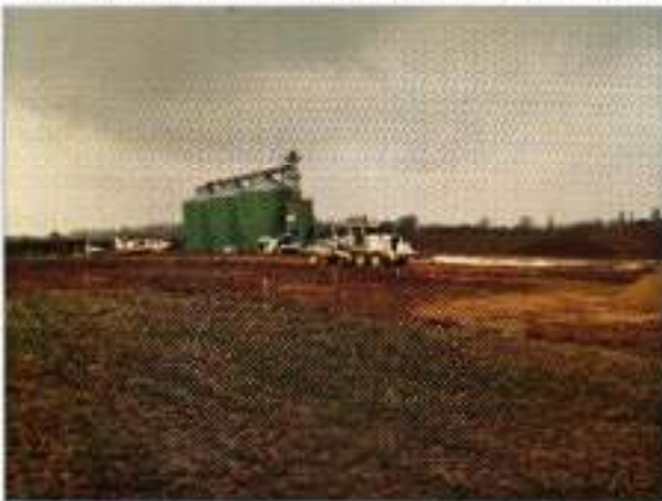
La zone de stockage en chantier
