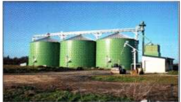
Le nouveau silo UCAC à Saint-Sulpice
